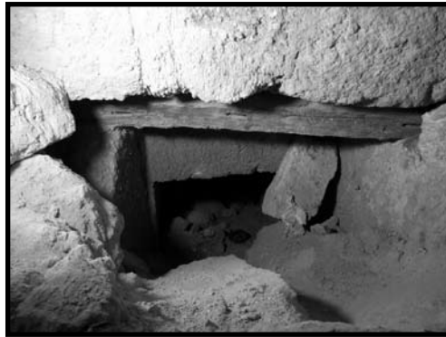
איור 16: משקוף העץ בכניסה למרתפים המקומרים
