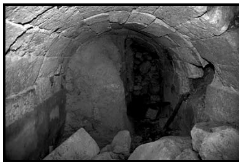
איור 18: תמיכות מתקופת בר-כוכבא בחלק הדרומי של המרתפים המקומרים
