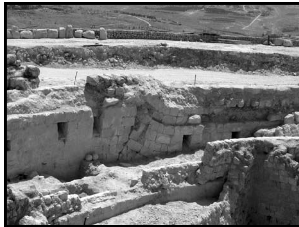
איור 11: קריסה ו"קריעה" בחלקו הדרומי של קיר ההיקף החיצוני
